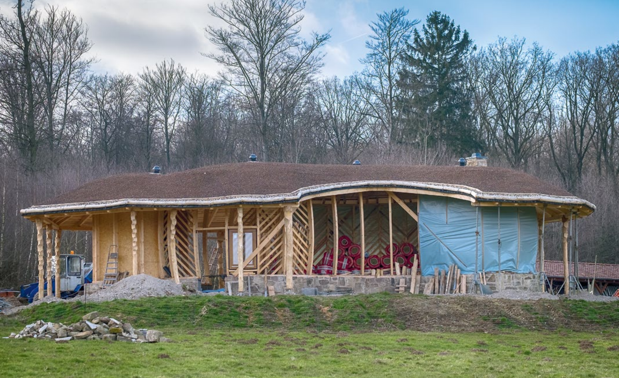
Der Rohbau des Bienenhauses in der Ansicht von Süden.
