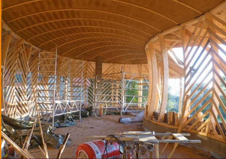
Das Holzskelett der Wände wird mit Strohballen geschlossen und mit Lehm verputzt.
